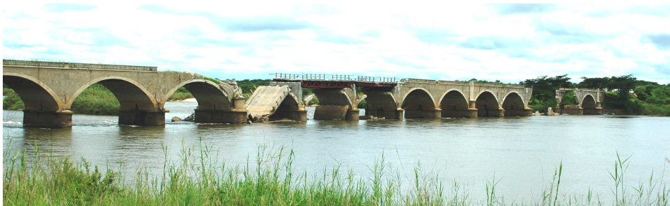
Figura 1. Vista geral da Ponte
