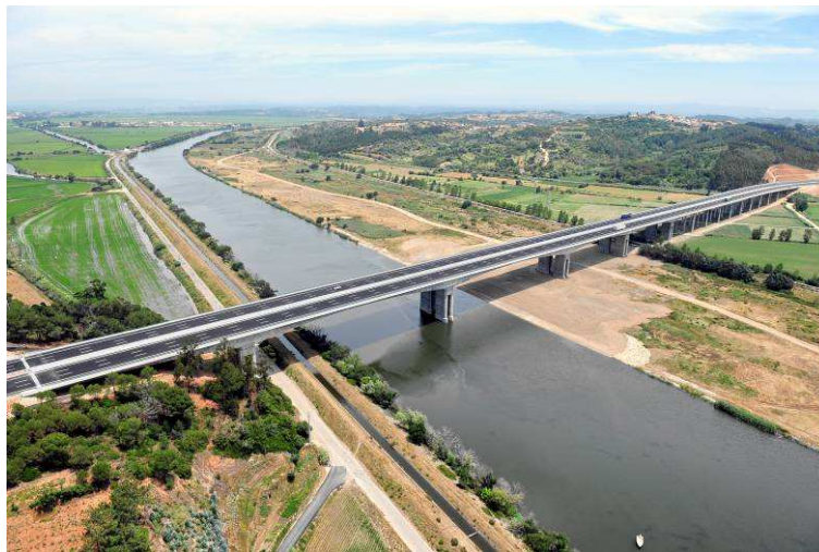
Figura 1. Vista geral da obra.
