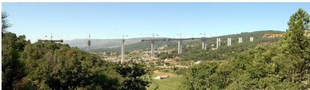
Figura 1: Vista geral N/S em 09/08/06
